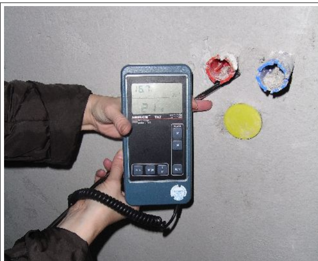
Bagno: Perdita allacciamento idraulico: 2,11 m/s
